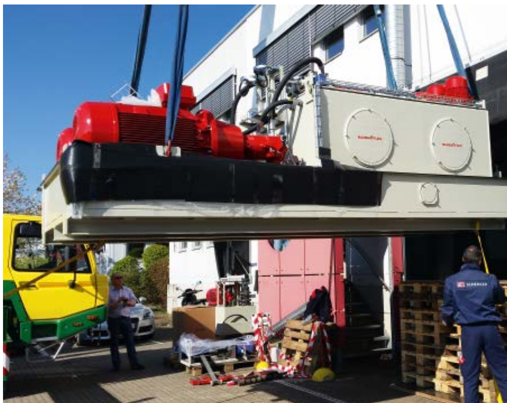
» Alle haben ein bisschen weiche Knie, als das 10 t schwere Aggregat durch die Luft schwebt. » Everyone watches in suspense as the ten-tonne aggregate unit floats through the air.
